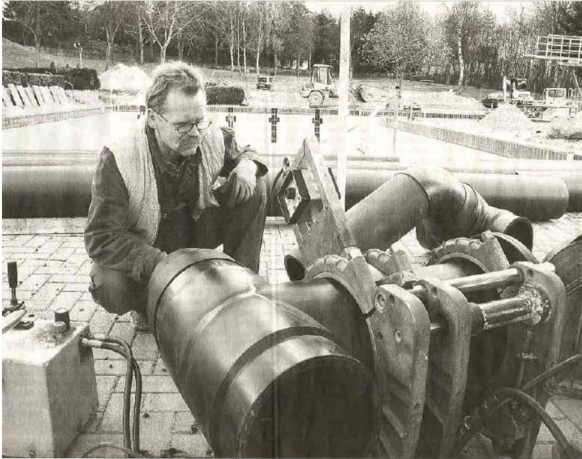
In akribischer Kleinarbeit setzen zurzeit Mitarbeiter eines Unternehmens, das sich auf die Sanierung von Schwimmbädern spezialisiert hat, die einzelnen Rohrstücke für die neue Technik im Freibad Birlenbach zusammen. ■ Foto: Uli Pohl
