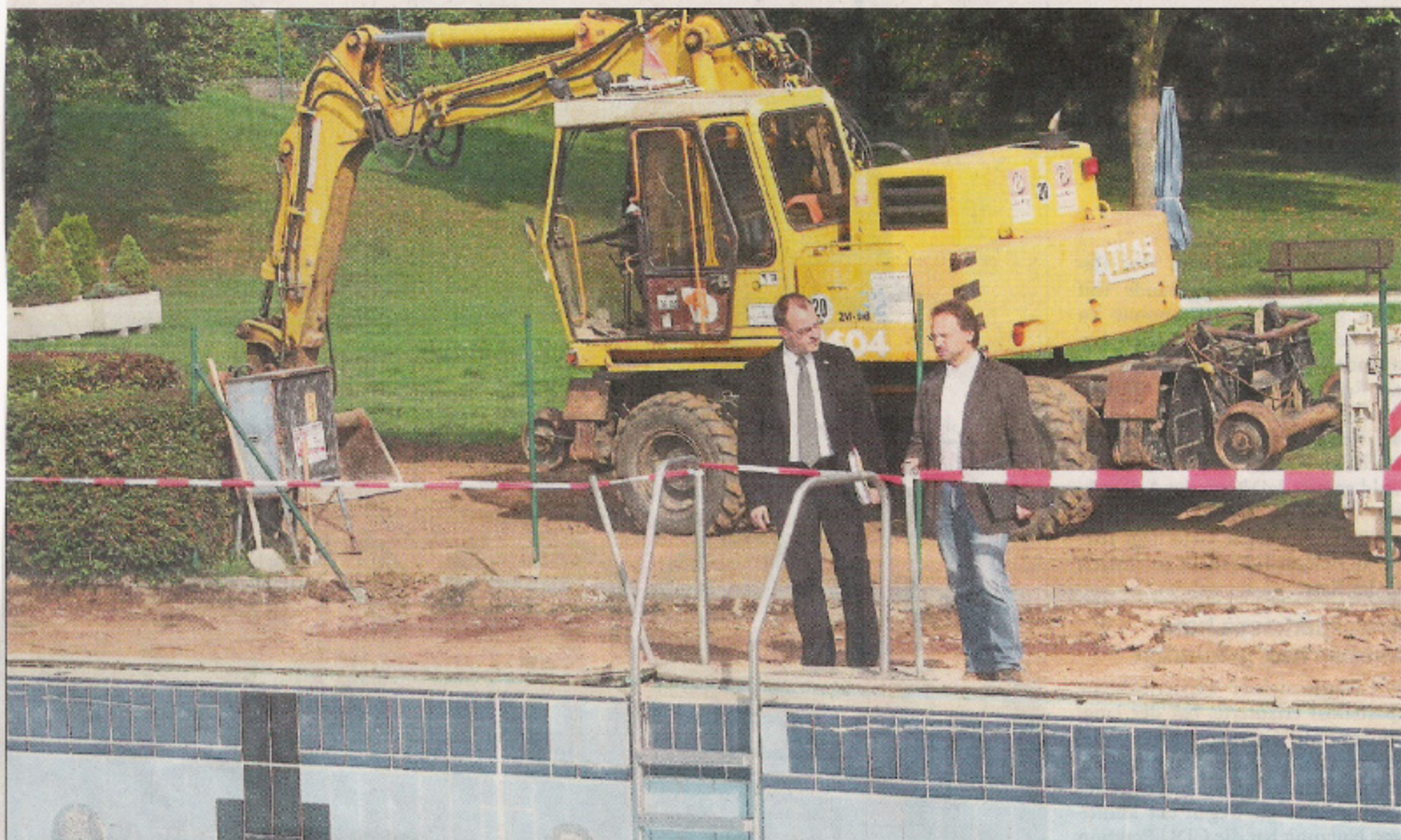
An der Baustelle im Freibad: Michael Schnatz und Projektleiter Oliver Martin.
